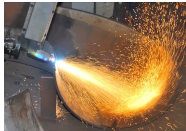
▲ 自动焊接 Automatic Welding
